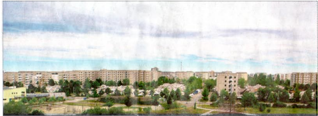
Das Abrissgebiet im Juni 2005.
